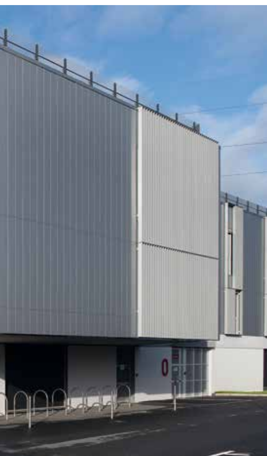
Coursive sud RdC bas
